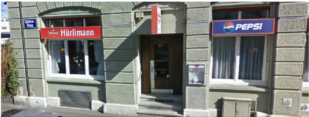
Ehem. Rest. Gessnerallee, Schützengasse 32, 8001 Zürich
