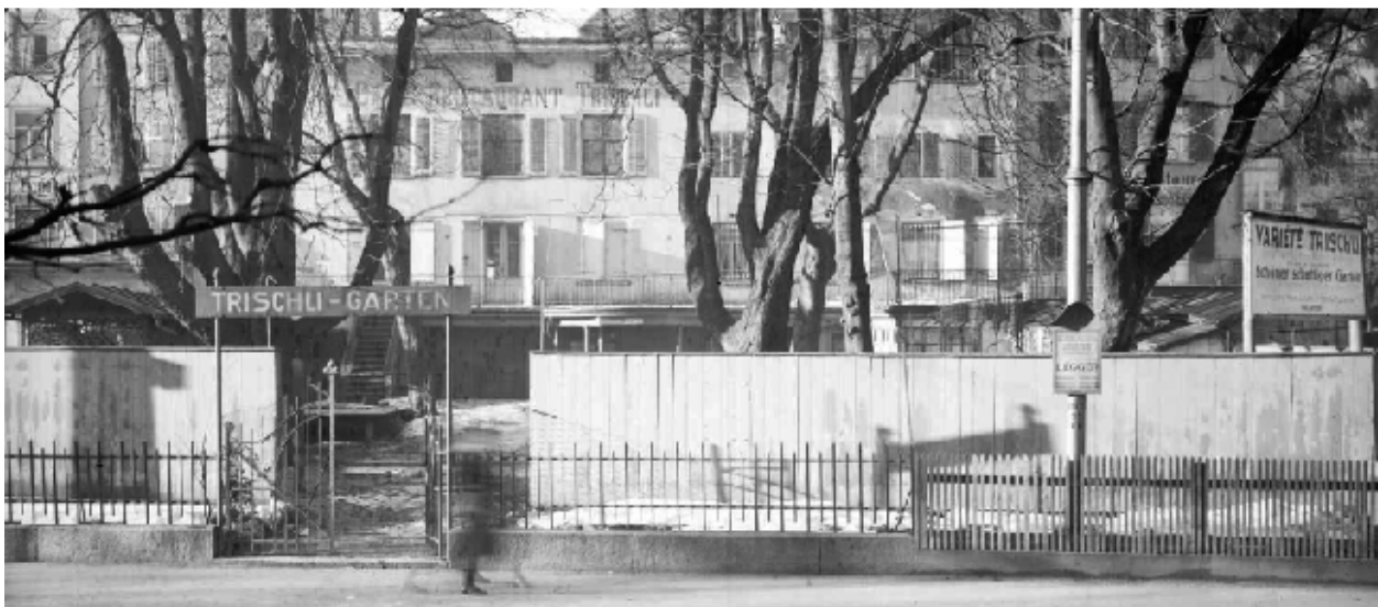
Rest. Trischli, Brühlgasse 15, 9000 St. Gallen (vor Neubau 1935)
